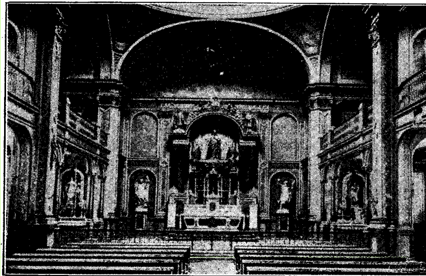
SANCTUAIRE ET AUTEL DE LA CHAPELLE DE LA MAISON-MÈRE.
