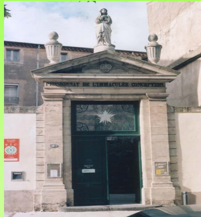
Portail d'entrée du P.I.C.
